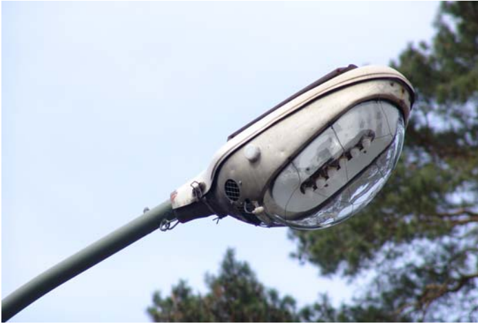
Berliner Gas-Reihenleuchte „U13H“ am Peitschenmast (6-flammig) und 4-flammige Aufsatzleuchte Typ „U7“
