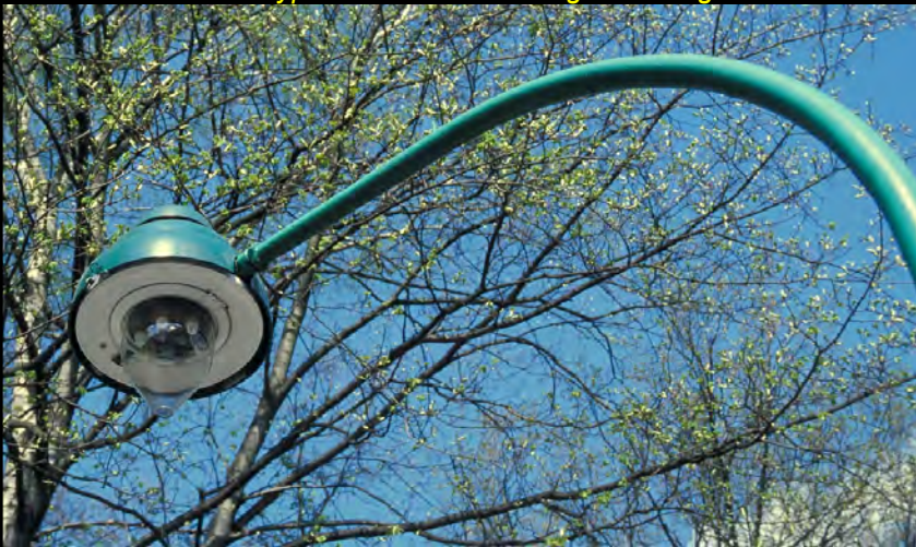
Gasansatzleuchten Typ BAMAG U11 an Bogen-Auslegermasten
