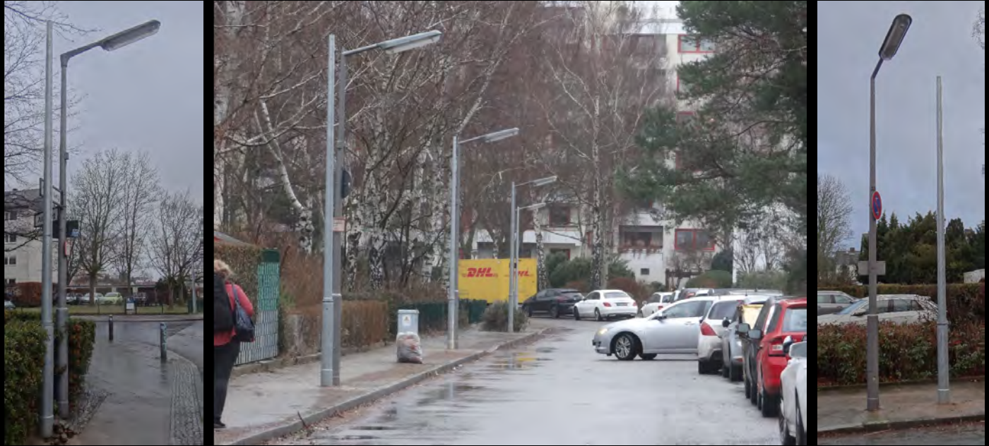
Austausch der Langfeldleuchten und Masten in Buckow. Links Kalksteinweg, in der Mitte und rechts Bernsteinring. Diese Leuchte stand bisher vieltausendfach in Berlin (Westteil). In Buckow wurden sie nach Errichtung der Siedlung aufgestellt. Bilder Nico Wolf
