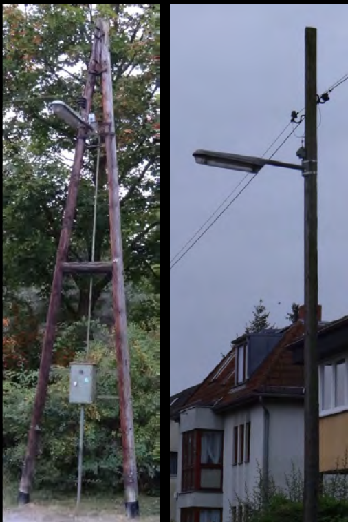
Auch Langfeldleuchten an Holzmasten mit Freileitung sind in Berlin anzutreffen. Bild Nico Wolf
