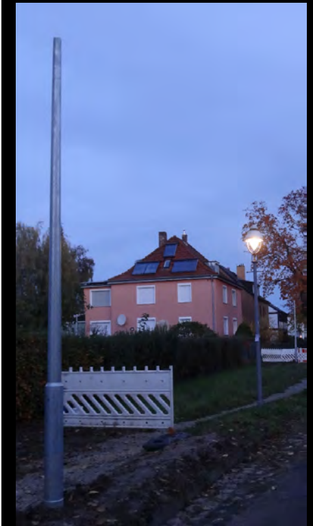
Lichtenrade, Halker Zeile (2023). Die LED-Leuchte „Townguide“ ersetzt die Gasaufsatzleuchte „U7“
