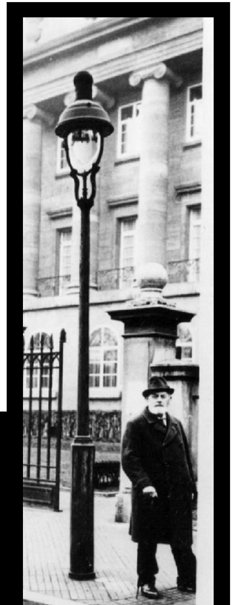
Unterschiedliche Kandelaber mit der Gasleuchte „Modell Frankfurt“ von Rech. Links auf „Sachsenhäuser Kandelaber“ in der Bockenheimer Landstraße, darunter auf Stühlen-Kandelaber in der Kettelerallee (vermutlich Rech-Modell, könnte eventuell aber auch ein Bamag-Modell sein, oben und unten auf einem unbekanntem Gusskandelaber-Typ, oberes Bild unbekannter Standort, unteres Bild Turmstraße. Bilder Institut für Stadtgeschichte Ffm.
