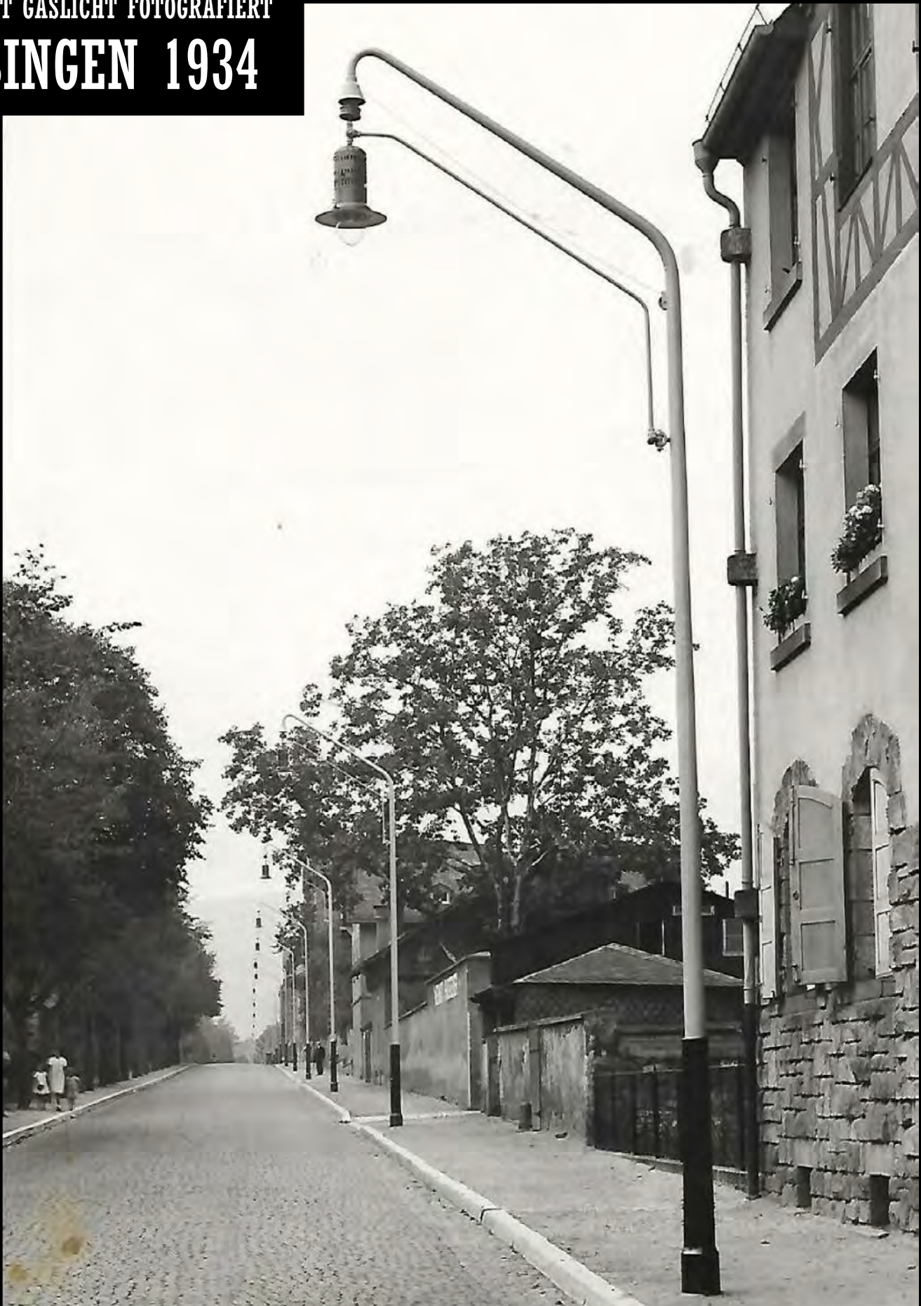
Gashängeleuchten in Bingen (Oktober 1934). Die Maste mit Herablass-Vorrichtung. Die Leuchte ist von BAMAG, Modell A 13/14 und entspricht denen, die z.B. in Berlin als Beleuchtung für die öffentlichen Pissiors („Café Achteck“) verwendet wurden, hier allerdings vierflammig und mit einer 206mm-Glasglocke. Bildquelle H. Morganus/GICS-Archiv
