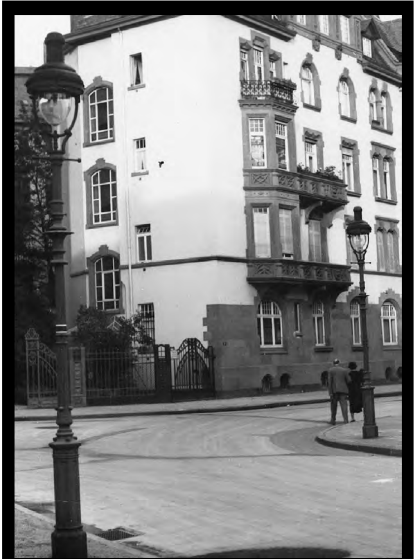
Zwei Frankfurter Vorort-Gusskandelaber („Sachsenhäuser“) mit der Rech-Gasaufsatzleuchte „Modell Frankfurt“ im Westend (Hansaallee). Die vordere Leuchte brennt nicht die ganze Nacht durch und ist mit einem weiß-roten Schild versehen. Diese Markierung wird seit einiger Zeit auch bei den Düsseldorfer Gaslaternen verwendet. Bild Institut für Stadtgeschichte S7A 1998/13089
