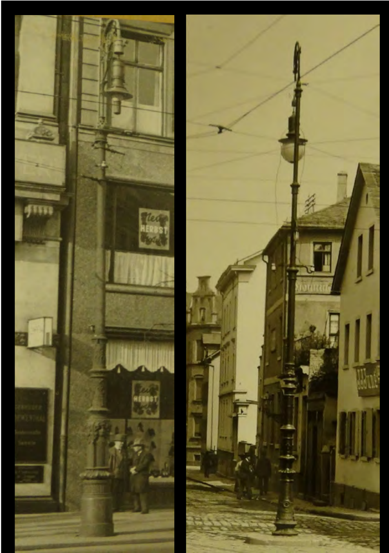
Für die elektrische Beleuchtung wurden auch reich verzierte Hängelichtmaste eingesetzt, viele davon existierten in den 1950er Jahren noch. Unten Sockel eines Mastes, der leider nur kurze Zeit an der Battonnstraße stand. Bild Nico Wolf
