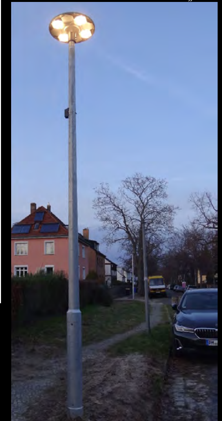
Lichtenrade, Halker Zeile (2023). Die LED-Leuchte „Townguide“ ersetzt die Gasaufsatzleuchte „U7“
