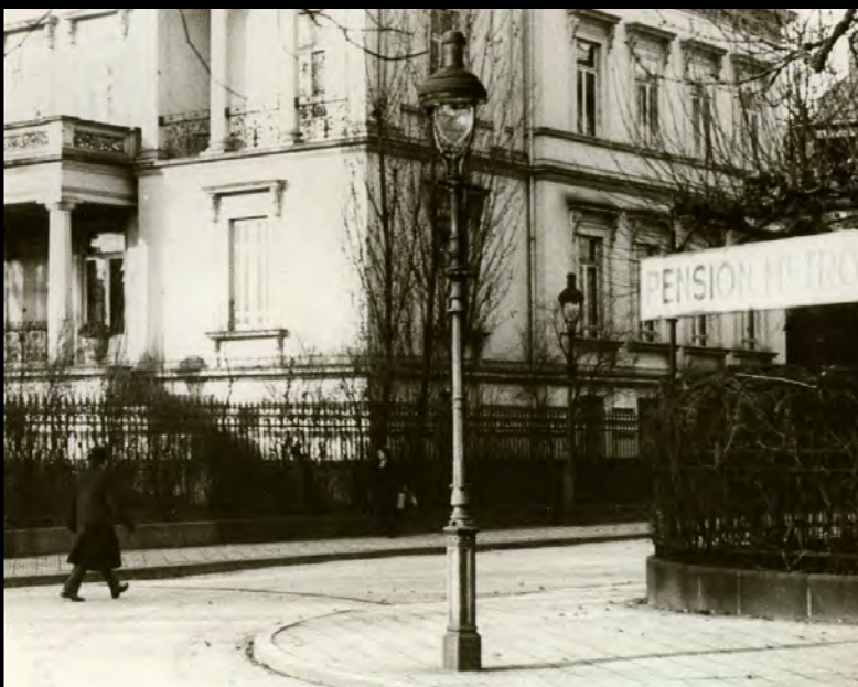
Unterschiedliche Kandelaber mit der Gasleuchte „Modell Frankfurt“ von Rech. Links auf „Sachsenhäuser Kandelaber“ in der Bockenheimer Landstraße, darunter auf Stühlen-Kandelaber in der Kettelerallee (vermutlich Rech-Modell, könnte eventuell aber auch ein Bamag-Modell sein, oben und unten auf einem unbekanntem Gusskandelaber-Typ, oberes Bild unbekannter Standort, unteres Bild Turmstraße. Bilder Institut für Stadtgeschichte Ffm.
