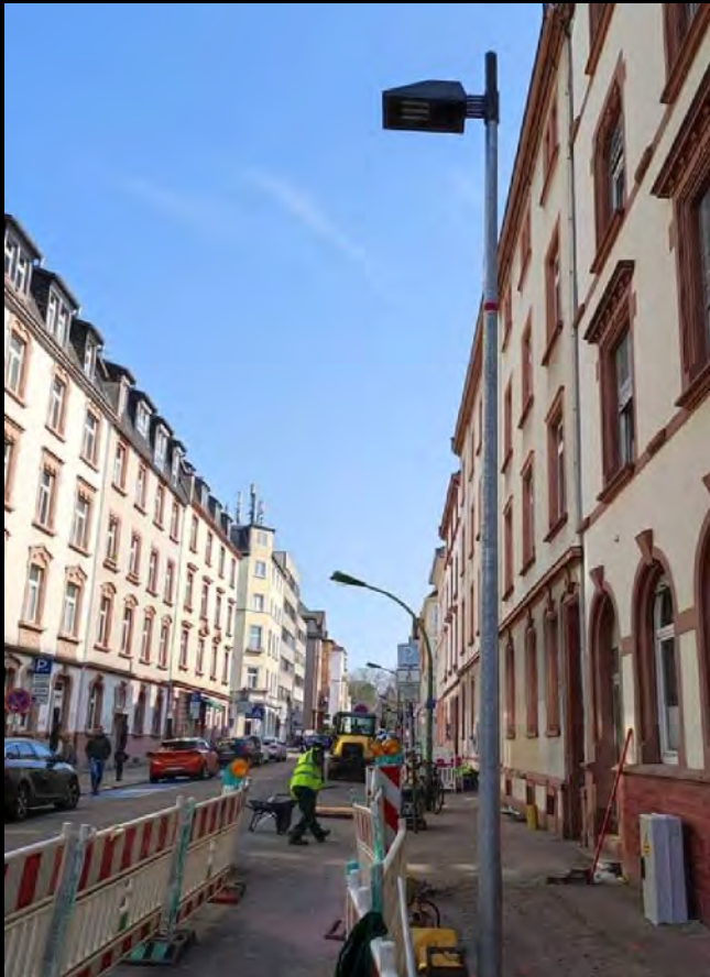
Oben: Austausch von Gasreihenleuchten durch hohe elektrische Leuchten (Am Weingarten); rechts neu aufgestellte Gasaufsatzleuchten-Attrappe mit LED (nach kurzer Zeit schon ziemlich beschmutzt) in der Riederwald-Siedlung; unten links Gasreihenleuchten-Attrappen mit LED im Grüneburgweg; rechts Abbau der Gasreihenleuchten und Ersatz durch technische Kofferleuchten an Hochmasten (Kreuznacher Straße). Bilder Slg. ProGaslicht
