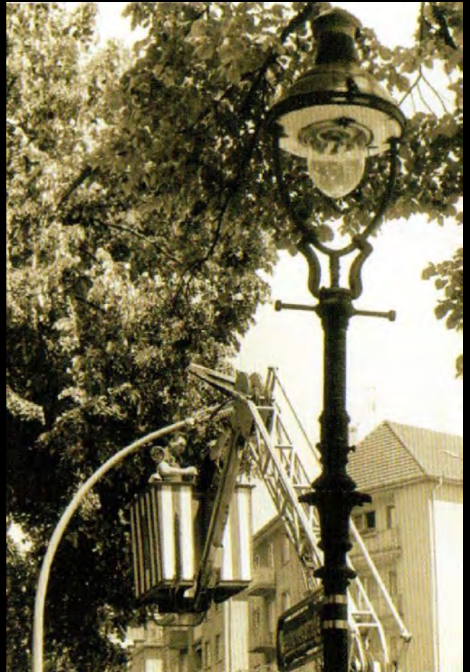
Austausch einer Gasaufsatzleuchte Bamag U5, ähnlich wie „Modell Köln Köln durch eine GICS-Gasreihenleuchte L56. Bild Main-Gaswerke
