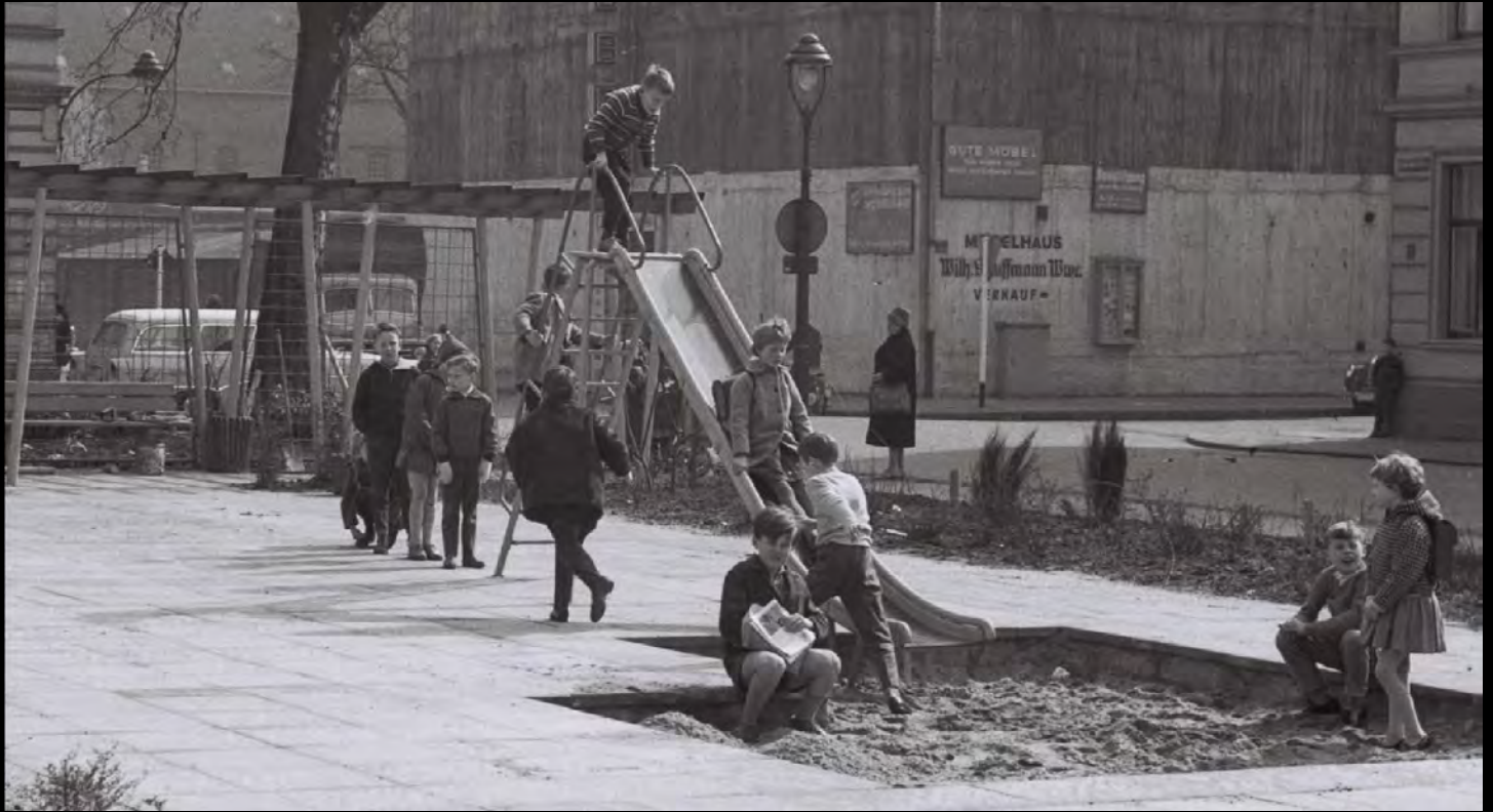
Rech-Gasleuchten am Blumenplatz (1957). Links hinten Wand-Stahlausleger mit Ansatzleuchte Modell „Modern“, in Bildmitte Aufsatzleuchte Modell „Modern“ mit Verlängerungsstück auf Stahlmast.
