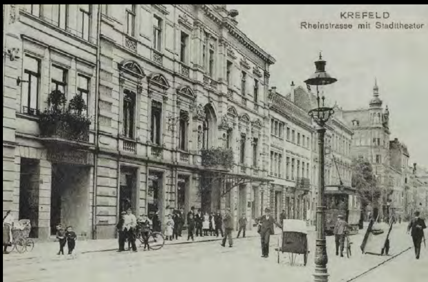
Die Rheinstraße mit dem Stadttheater um 1906. Rundmantellaterne (mit "Ritterdach") ohne Fernzündung mit Stehlichtdoppelbrenner auf Gusskandelaber Kölner Bauart. Bild Postkarte/Sammlung ProGaslicht
