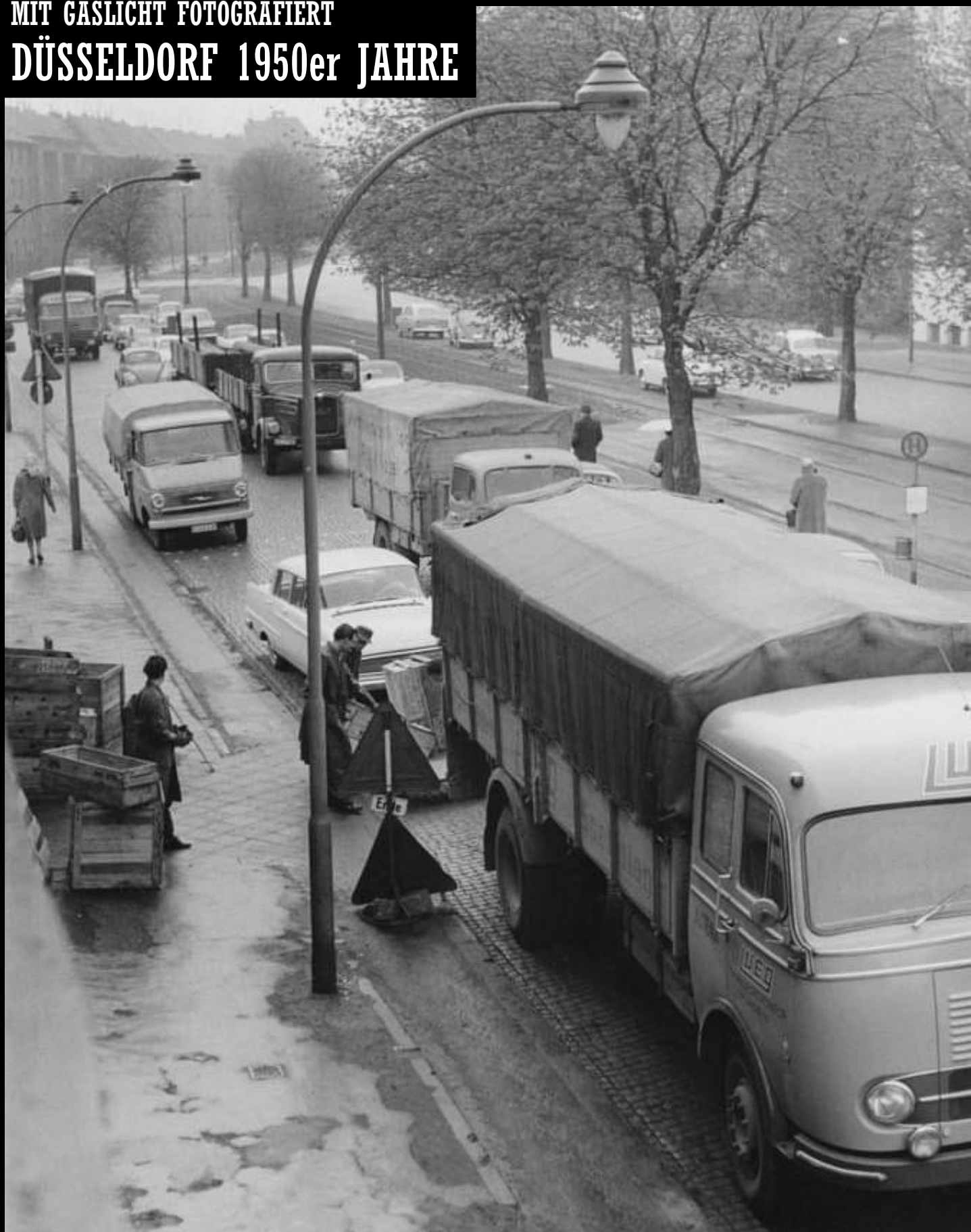
Die Kettwiger Straße in den 1950er Jahren mit Gasansatzleuchten an sehr hohen Stahlmasten, Modell „Dresden“ von Rech. Bildquelle unbekannt/Slg. ProGaslicht
