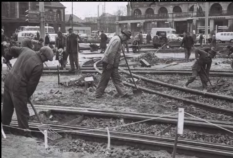
Gleisbau am Hauptbahnhof, im Hintergrund das Hansahaus. Bildquelle unbekannt
