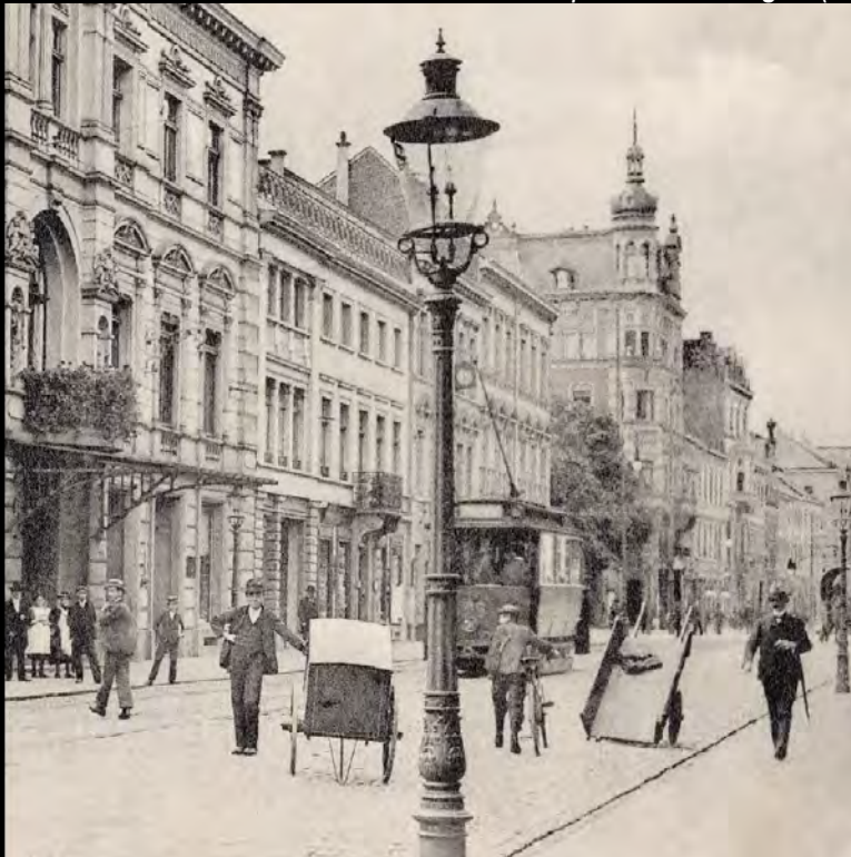
Links Ritter-Rundmantellaterne mit doppeltem Stehlicht, ohne Fernzündler am Stadttheater in der Rheinstraße; rechts Vierecklaterne und Kandelaber von Puricelli, Stehlicht ohne Fernzündler in der Steinstraße am Stadtgarten (beides um 1906). Bilder Postkarten/Sammlung ProGaslicht
