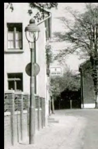
Rech-Modell „Freilicht“ mit jüngerer Dachform und schlankem Schornstein auf Kölner Kandelaber. Die Laterne ist ausgestattet mit BAMAG-Zünder und Einbaubrenner. Bildausschnitt Stadtarchiv Krefeld
