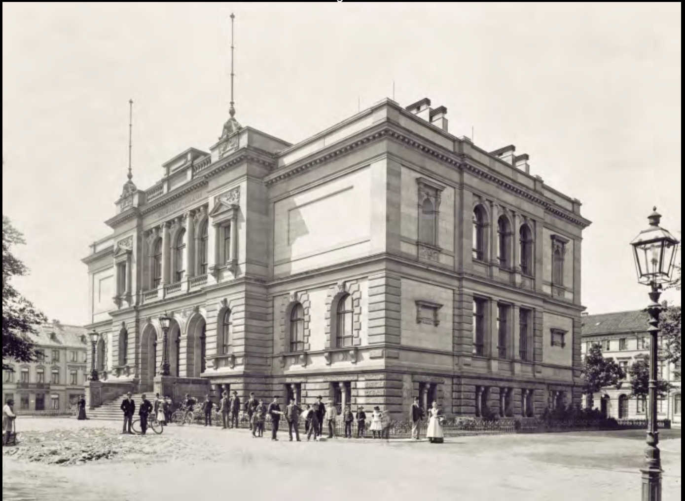
Puricelli-Laterne und -Kandelaber vor dem Kaiser Wilhelm Museum (1910). Ausgestattet mit doppeltem Stehlicht ohne Fernzündler. Das Museum gibt es auch heute, die große Freitreppe wurde leider entfernt. Bild Hugo Koch
