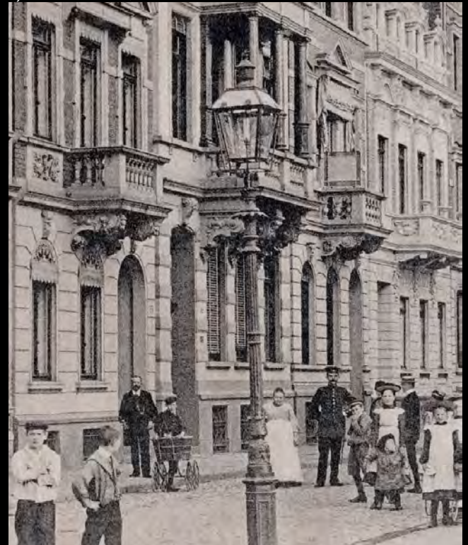
Links Ritter-Rundmantellaterne mit doppeltem Stehlicht, ohne Fernzündler am Stadttheater in der Rheinstraße; rechts Vierecklaterne und Kandelaber von Puricelli, Stehlicht ohne Fernzündler in der Steinstraße am Stadtgarten (beides um 1906). Bilder Postkarten/Sammlung ProGaslicht
