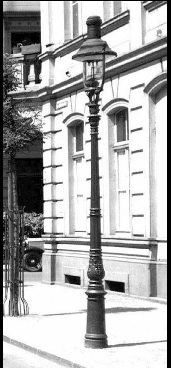
Rech-Modell „Freilicht“ mit jüngerer Dachform und schlankem Schornstein auf Kölner Kandelaber. Die Laterne ist ausgestattet mit BAMAG-Zünder und Einbaubrenner. Bildausschnitt Stadtarchiv Krefeld
