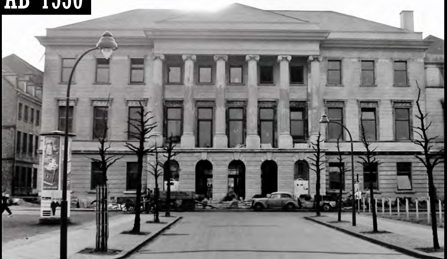
Das Rathaus nach seiner weitgehenden Wiederherstellung. Die klassizistische Bebauung seitlich der Straße ist verschwunden. Das schöne Gaslicht ist tatsächlich geblieben, nur die Leuchten haben gewechselt. Statt „Freilicht“-Laternen auf Kölner Gusskandelabern nun Gasansatzleuchten Modell BAMAG U11/große Variante an Benteler-Stahlmasten mit einem Meter Ausladung. Bild Karl Heinz Lengwenings (1955)
