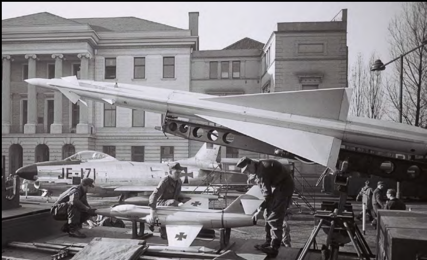
Und nochmal das Rathaus. Davor wird militärisches Gerät präsentiert. Rechts ein Stahlmast mit Doppelausleger und Gasansatzleuchten, sichtbar das Rech-Modell „Modern-konkav“ (eine ist nicht auf dem Bild). Quelle: facebook
