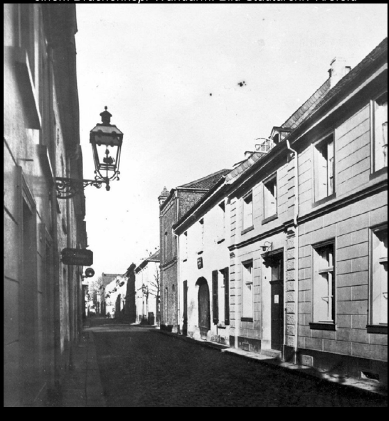
Oben: „Puricelli-Laterne“ auf Kölner Stadtkandelaber, ausgestattet mit Stehlicht vor dem Issumer Turm. Bild Erwin Quedenfeldt; unten mit Stehlicht und BAMAG-Fernzünder auf einem Drachenkopf-Wandarm. Bild Stadtarchiv Krefeld
