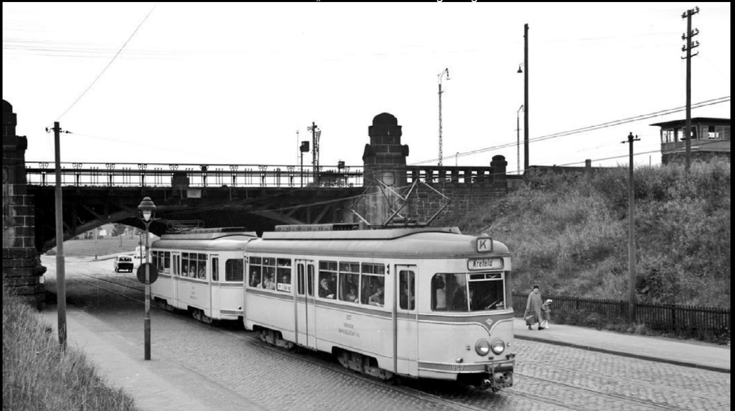
Die Bahnunterführung Voltastraße im Jahr 1958. Ein Straßenbahnzug der Linie K unmittelbar am Krefelder Hauptbahnhof. Links abgetreppter Stahlmast mit Rech-Gasaufsatzleuchte Modell Modern und Blohmglocke. Bildquelle Eisenbahnmagazin
