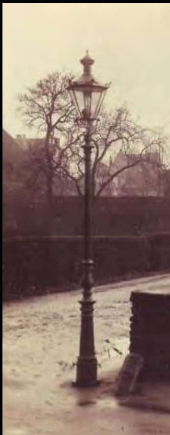
GICS-Modell Nr. 444 mit BAMAG-Zünder und Einbaubrenner auf Kandelaber ähnlich dem Alt-Düsseldorfer, Standort Schönwasserhof. Bildquelle unbek.
