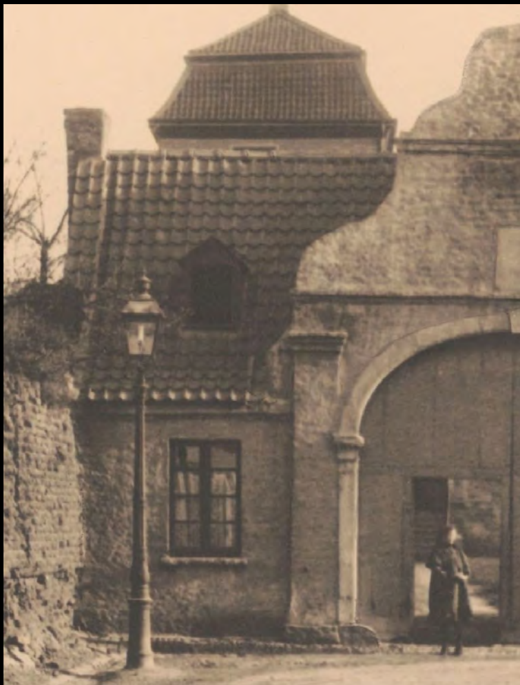
Oben: „Puricelli-Laterne“ auf Kölner Stadtkandelaber, ausgestattet mit Stehlicht vor dem Issumer Turm. Bild Erwin Quedenfeldt; unten mit Stehlicht und BAMAG-Fernzünder auf einem Drachenkopf-Wandarm. Bild Stadtarchiv Krefeld
