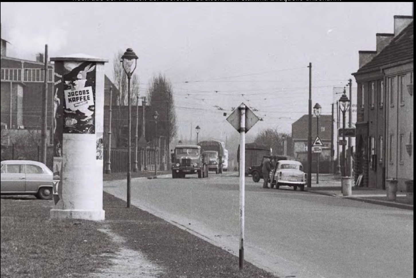
Die Ritterstraße im Jahr 1960 mit Rech-Aufsatzleuchten Modell „Modern“ auf Stahlmasten. Bildquelle unbekannt
