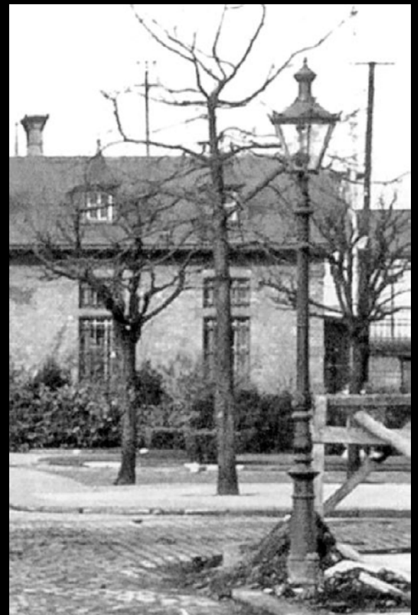
Links Abbildung der GICS-Leuchte Modell Nr. 444; rechts das gleiche Modell mit BAMAG-Zünder und Einbaubrenner auf einem Kandelaber ähnlich dem Alt-Düsseldorfer. Standort vor dem Uerdinger Bahnhof (Ende 1920er Jahre). Bildquelle unbekannt
