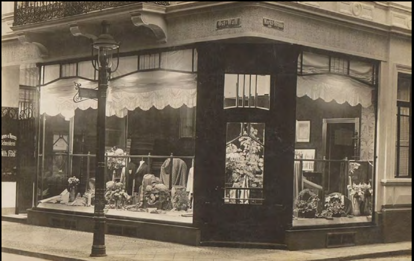
Gaslaterne Modell „Freilicht“ von Rech in der moderneren Form mit gebogenen Bügeln auf Kölner Kandelaber am Ostwall Ecke Marktstr 1925. Dahinter ein Bekleidungsgeschäft, die Auslage prächtig beleuchtet. Bildquelle unbekannt.
