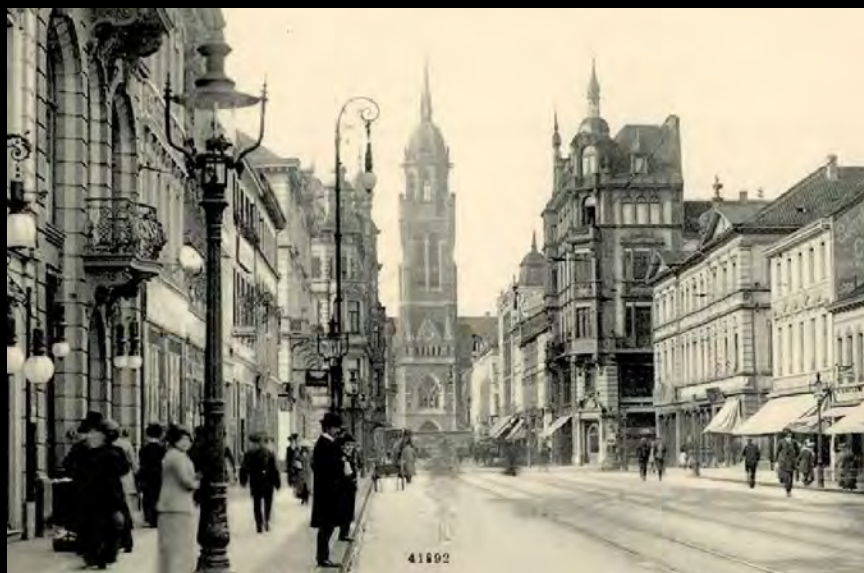
Modell Freilicht-konkav mit älterer Dachform und BAMAG-Fernzündern auf Kölner Stadtkandelaber in der Rheinstraße. Bild Postkartenausschnitt
