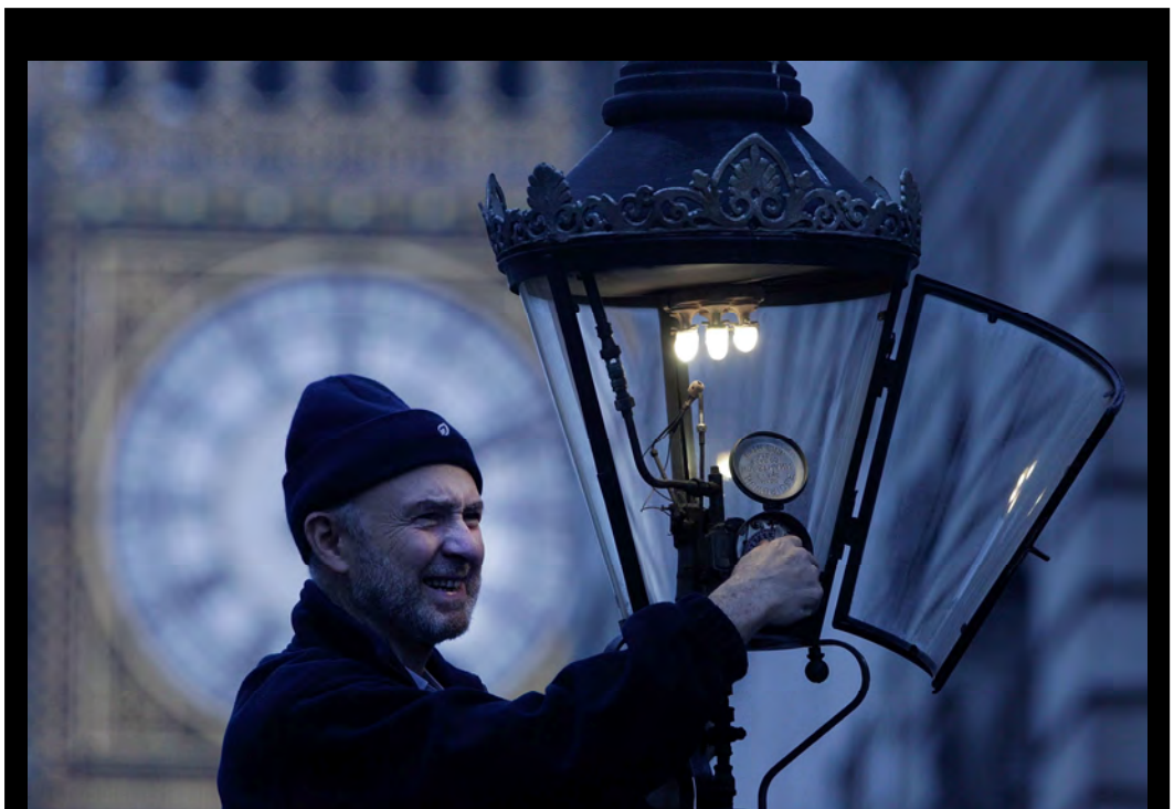
Martin Caufield von British Gas beim Aufziehen einer Horstmann-Zünduhr, im Hintergrund ist schemenhaft „Big Ben“ zu erkennen.
