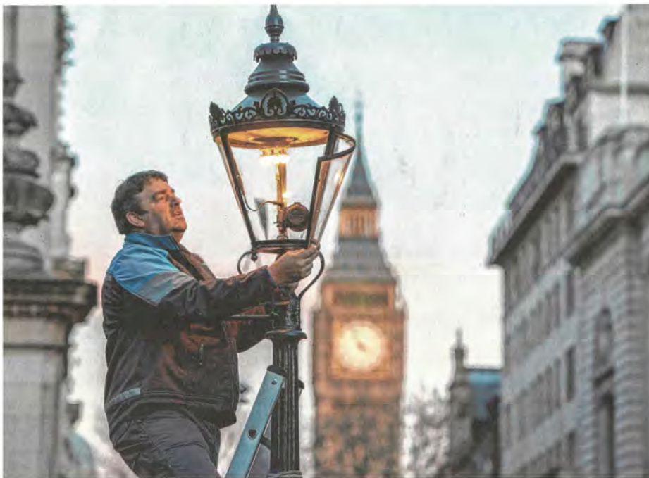
Früher zog der Laternenanzünder bei Anbruch der Dunkelheit mit einem langen Stab durch die Stadt und entzündete die Lampen. So ähnlich macht es Garry Usher in London noch immer – nur, dass er inzwischen ein mechanisches Uhrwerk aufzieht.
