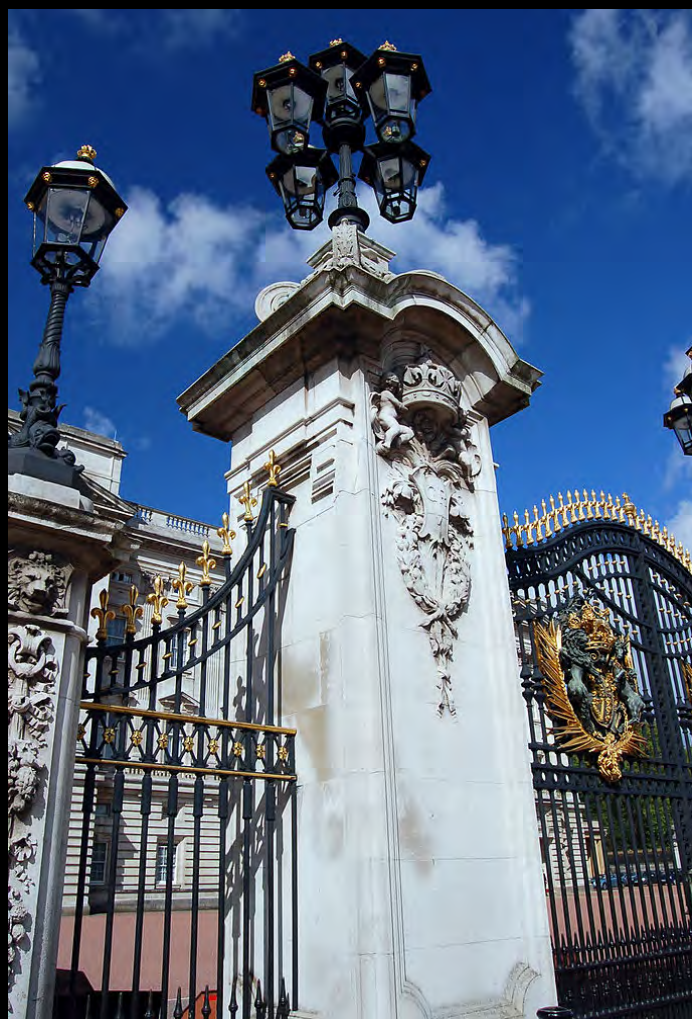
Die Gaslaternen am östlichen Eingang (Haupteingang) des Buckingham Palace sind einzeln oder in Gruppen auf Kandelabern montiert. Die Zündung erfolgt durch Horstmann-Schaltuhren. Ein interessantes Detail sind die goldenen Löwenköpfe am Dach der Laterne. Bilder Oliver Frühschütz und Sammlung ProGaslicht
