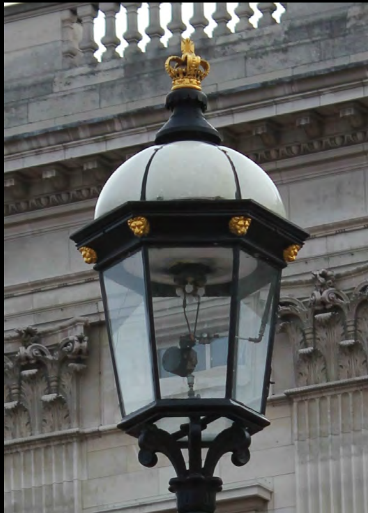
Die Gaslaternen am östlichen Eingang (Haupteingang) des Buckingham Palace sind einzeln oder in Gruppen auf Kandelabern montiert. Die Zündung erfolgt durch Horstmann-Schaltuhren. Ein interessantes Detail sind die goldenen Löwenköpfe am Dach der Laterne. Bilder Oliver Frühschütz und Sammlung ProGaslicht
