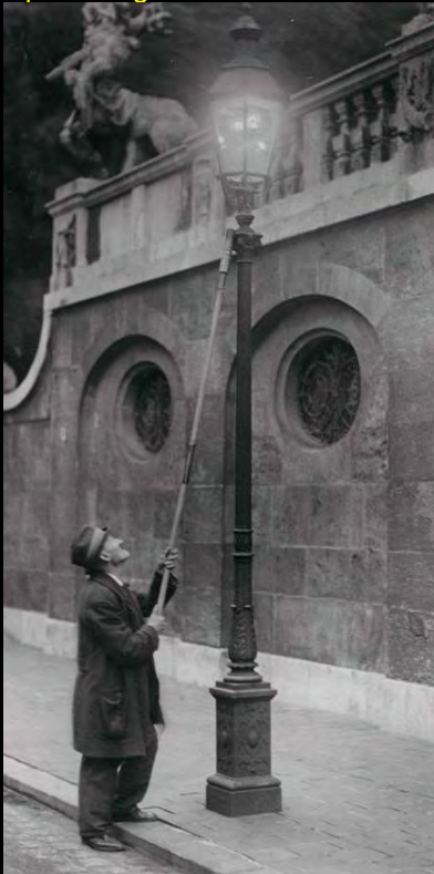
Oben: München-Ludwigsvorstadt um 1905; unten München-Neustadt, Volkartstraße 1931. Links Laternenanzünder mit typischer sechseckiger Alt-Münchner Gaslaterne und Kandelaber mit viereckigem Sockel. Oben rechts eine Vorstadt-Variante mit rundem Sockel, auch Bündelpfeilmasten sind aus München bekannt.
