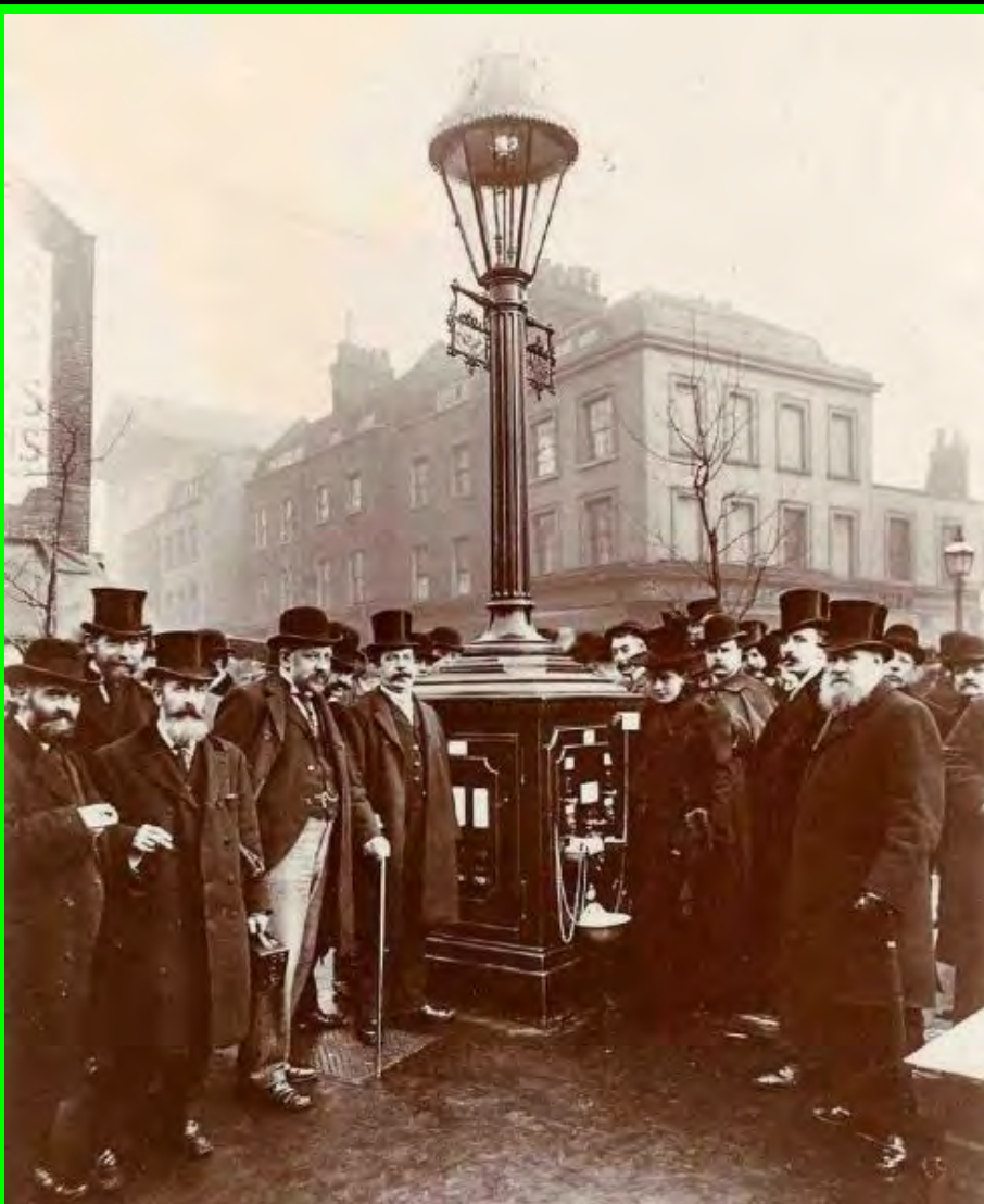
Gaskandelaber mit Heisswasserabgabe – und das breite Publikum staunt! Bild Islington Local History Centre, Finsbury Library
